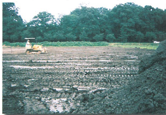
脱水ケーキ再成土土利用現場
